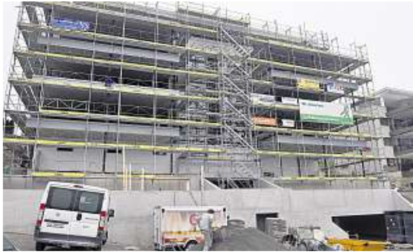
Rohbau Lindenweg 2: Hier entsteht das Mehrfamilienhaus Bella Vista. Das Risiko liegt beim Bauherrn, ob künftig alle Wohnungen realisiert werden können.
