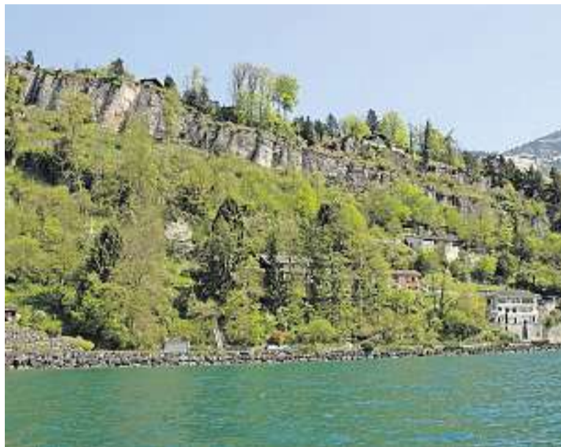
Im Gebiet Horlauri lebt man gefährlich: Fünf Häuser müssen abgebrochen und zehn Anwohner umgesiedelt werden.
